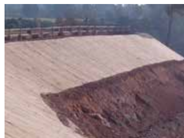
La partie protégée s'est bien végétalisée alors que l'érosion se poursuit sur la partie non recouverte.
