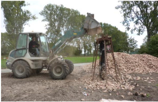
Figure 5 : Remplissage vertical des Rock rolls
