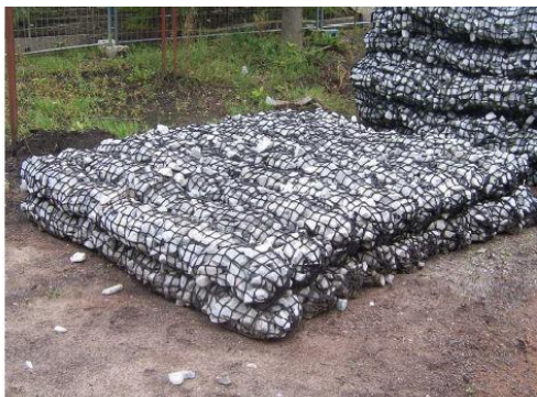
Figure 7 : Gabions tubulaires liés en matelas 2 x 2m
