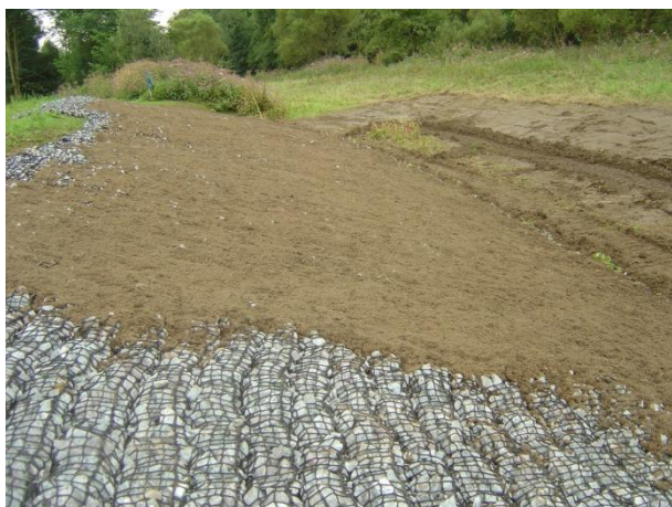
Figure 10 et 11 : Mise en œuvre de matelas de pierre en protection de talus, recouverts de terre et ensemenés et résultat de la végétalisation 3 mois après.
