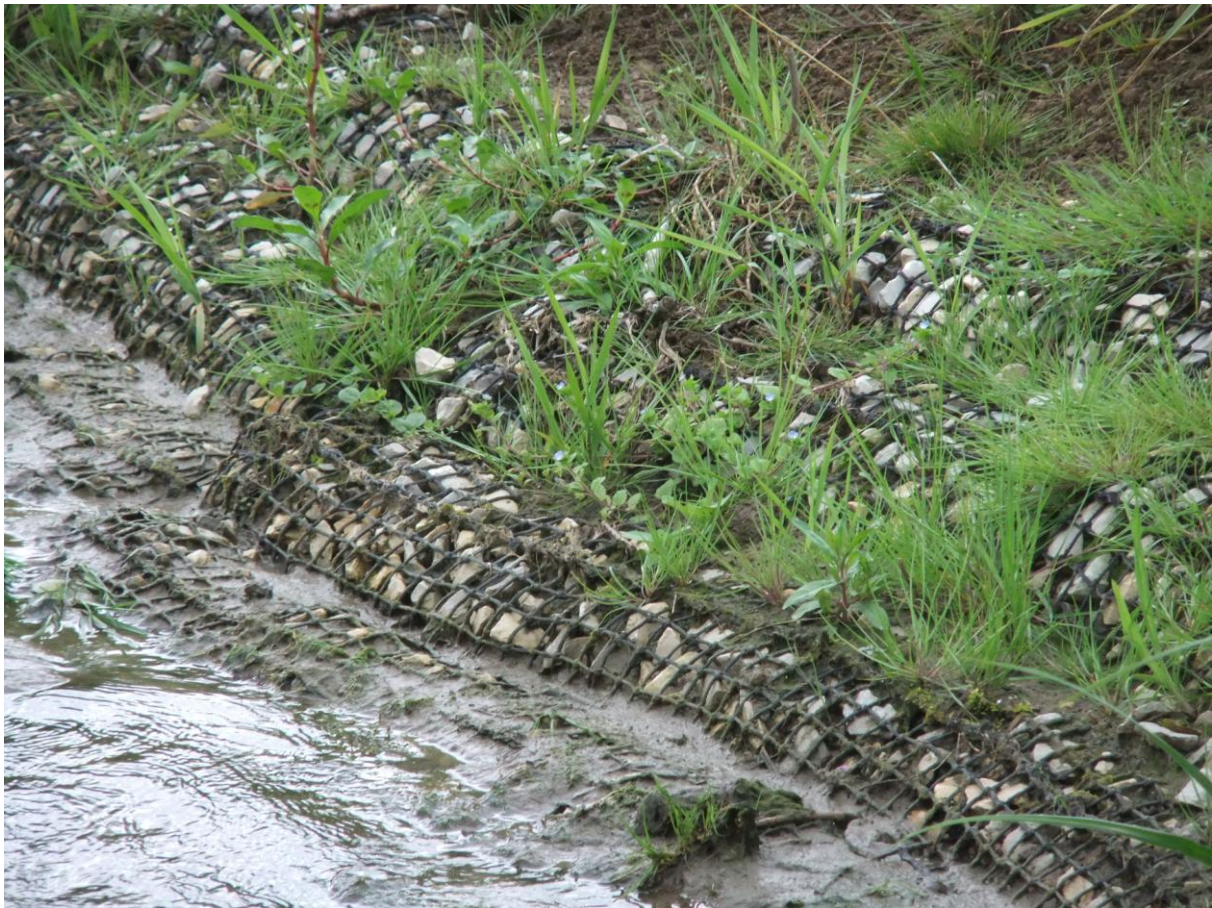
Figure 16 : Végétalisation spontanée des Rock rolls grâce à la sédimentation déposée par les crues.
