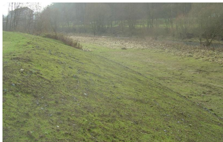
Figure 10 et 11 : Mise en œuvre de matelas de pierre en protection de talus, recouverts de terre et ensemenés et résultat de la végétalisation 3 mois après.
