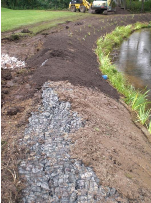
Figure 12 et 13 : Mise en œuvre de matelas de pierre en protection de talus, recouverts de terre, plantés et habillés en pied de géonattes coco prévégétalisées, et résultat de la végétalisation 1 an après.
